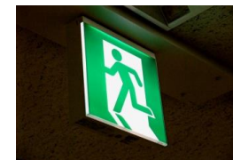
避難誘導照明
